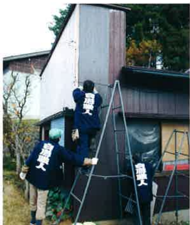
壁からの雨漏りを塞いでいます。
